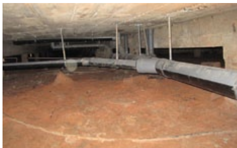
Das neue Kanalisationssystem unter dem Spitaltrakt
