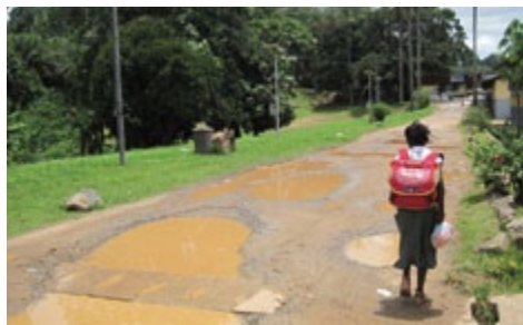
Wo Entwässerungen nicht unterhalten werden, gehen Strassen kaputt
