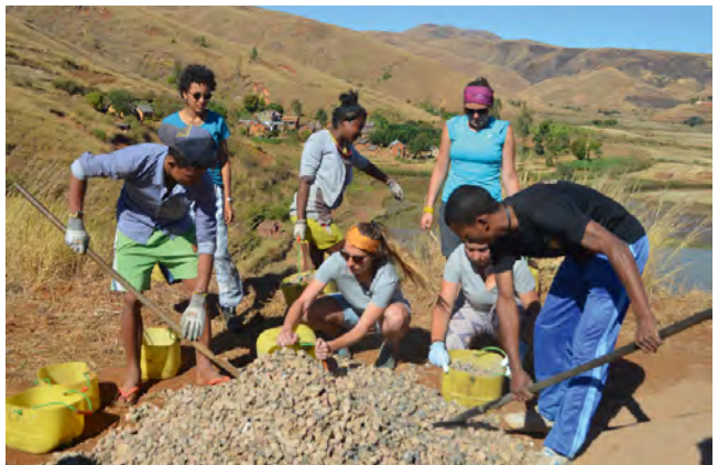
Arbeit auf der Baustelle in Madagaskar
