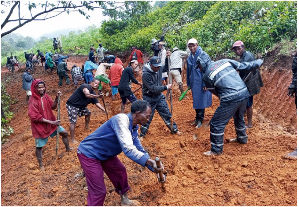
Bau der Strasse vom Dorf zum Kraftwerk
